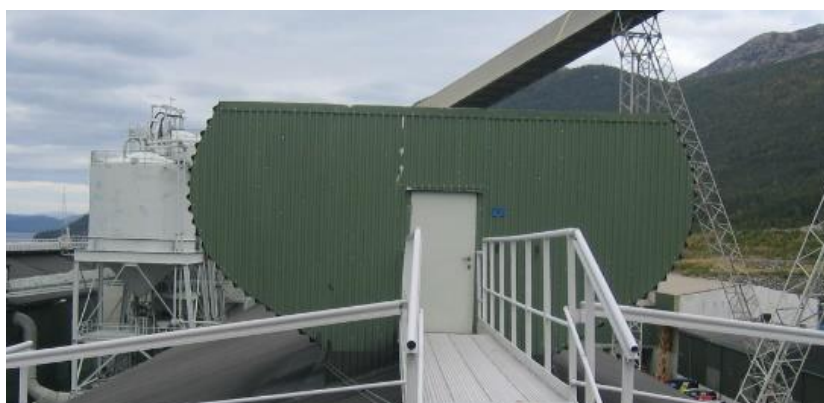
Figur 11.13 Elektrolysehall med tulipan taklyre. Foto: Håkon Skistad
