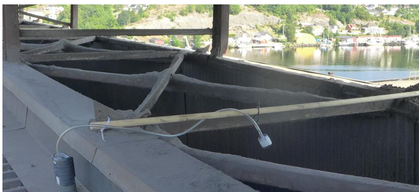
Figur 10.12 Prøvetaking av støvkonsentrasjon og støvsammensetning i taklyre.
