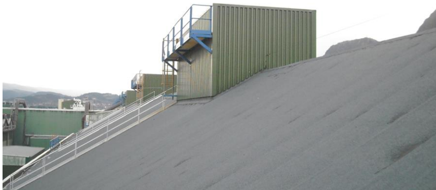
Figur 11.20 Rektangulær utløpsåpning/skorstein i en elektrolysehall. Foto: Håkon Skistad
