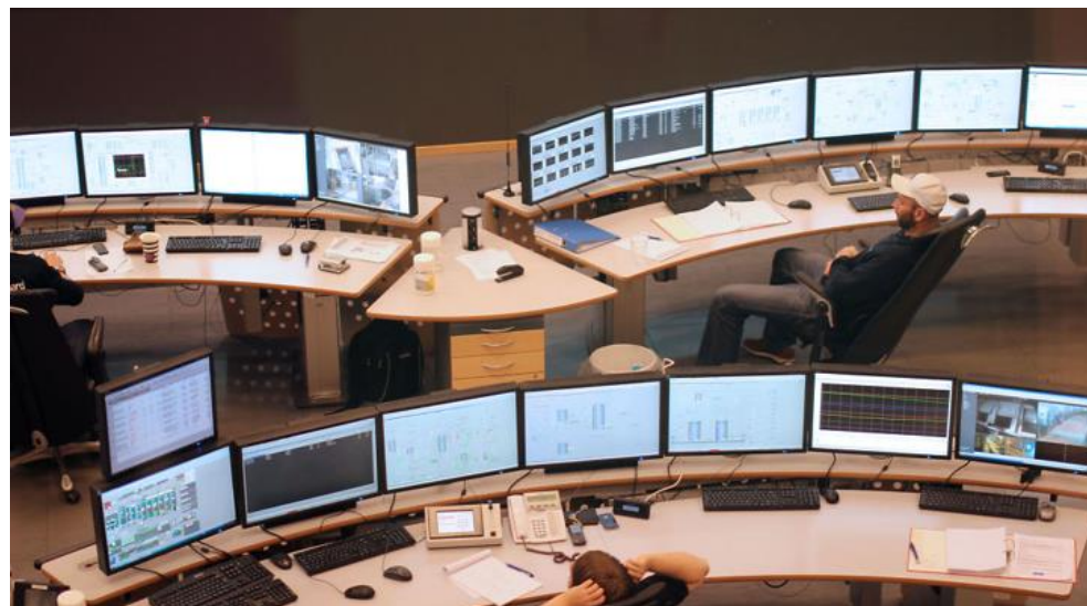
Borregaard sentrale kontrollrom
